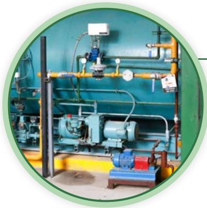
**Balanfarina.** Mejora en el sistema de producción de vapor a través de la incorporación de sistema de quemadores que permiten el cambio de diésel por GLP.
